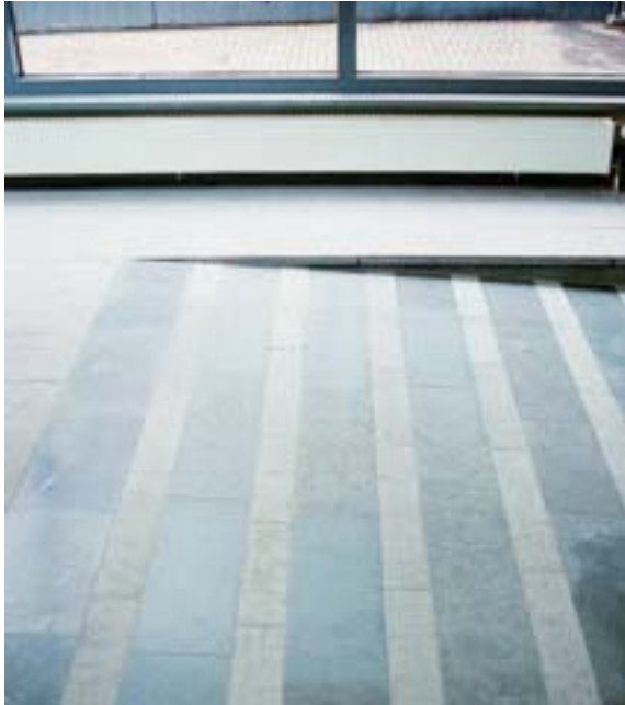
Fig 4.45 Lutande ramp av kalksten i kontorsentré. Läghuggna band utgör halkskydd och visuell markering.
