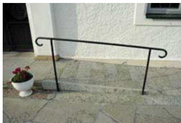
Fig 7.26 Låg ramp av kalksten för bättre tillgänglighet.
