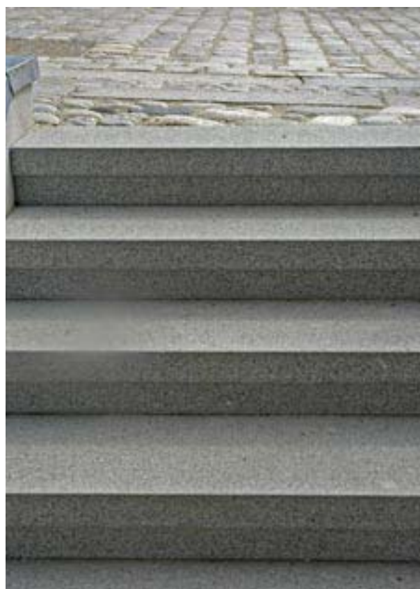
Fig 7.3 Beklädnadssteg av krysshämrad granit
