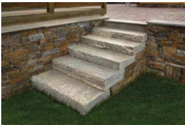
Fig 7.10 Blockstegstrappa av skiffer i anslutning till skifferkallmur.
