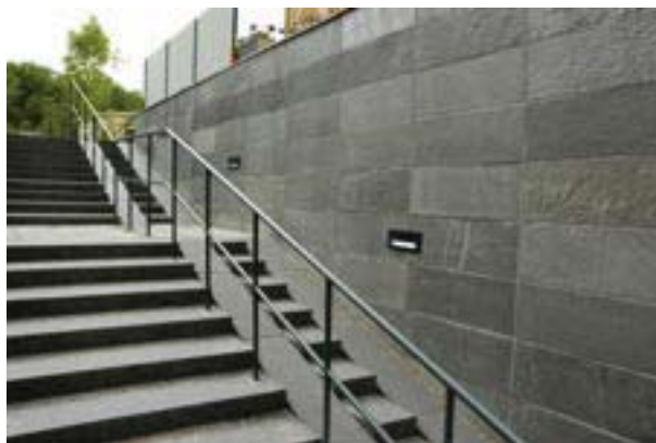
Fig 7.25 Barnvagnsramp integrerad i blockstegstrappa. Beklädnadsmur med skiffer.
