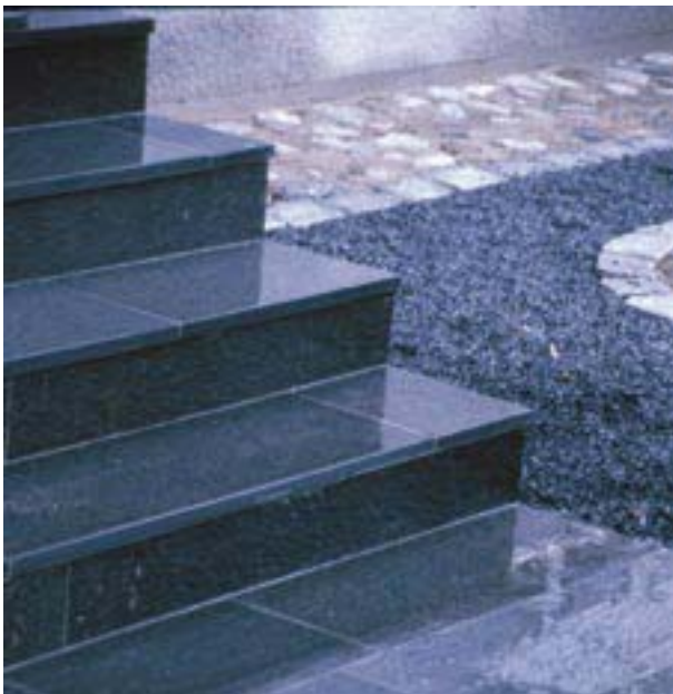
Fig 7.13 Beklädnadstrappa med steg av skiffer
