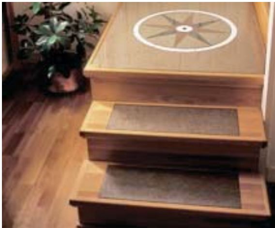
Fig 5.28 Trätrappa med kalksten infälld.
