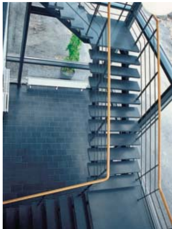
Fig 5.22 Trappa med fribärande steg på stålkonstruktion.
