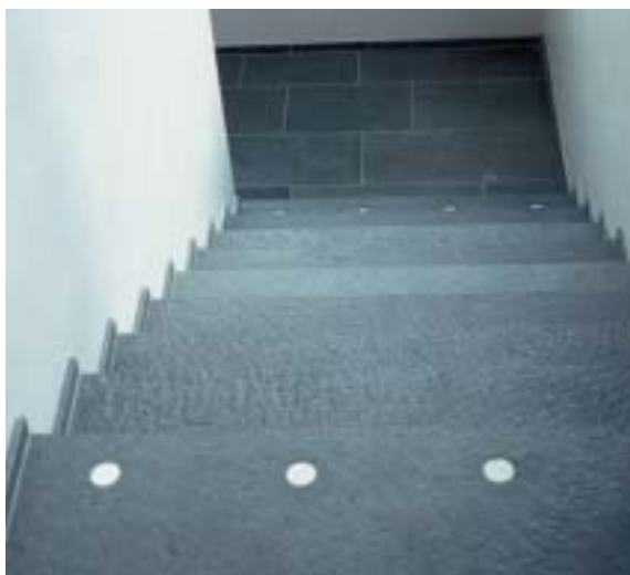
Fig 5.25 Infällda stencylindrar med avvikande kulör markerar trappans början och slut.
