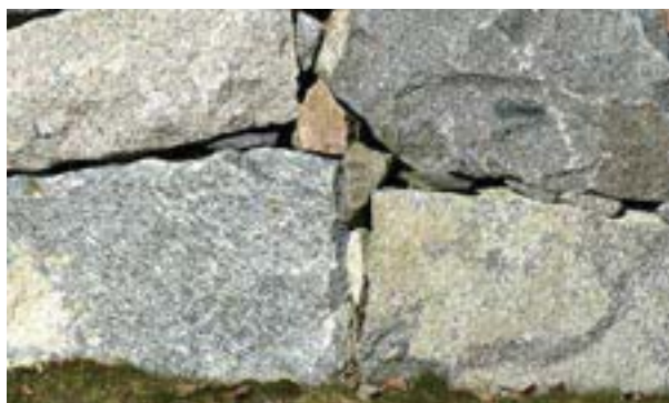
Fig 8.22 Mindre stenar, "skolsten" eller "lus" kilas in i stora fogar för att ge stabilitet.
