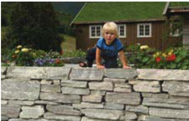
Fig 8.17 Kallmur av staplade skivor av skiffer
