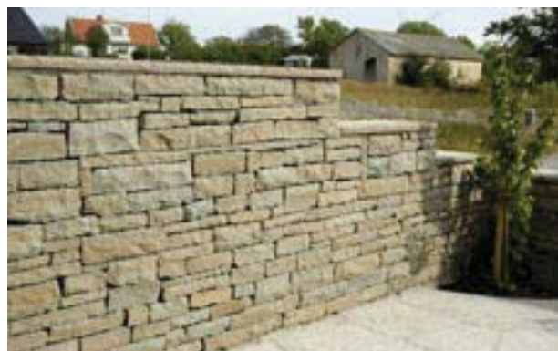
Fig 8.19 Kallmur av kalkstensskivor med avtäckning lagd i bruk
