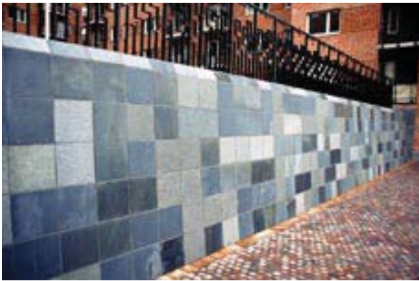
Fig 8.16 Beklädnadsmur. Skiffer med olika ytbearbetningar, klovyta, slipad och polerad. Kvadratiska plattor i ruttmönster.
