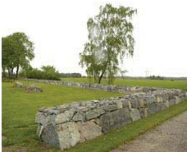
Fig 8.27 Kallmur av lokal sten, s k kyrkogårdsmur.
