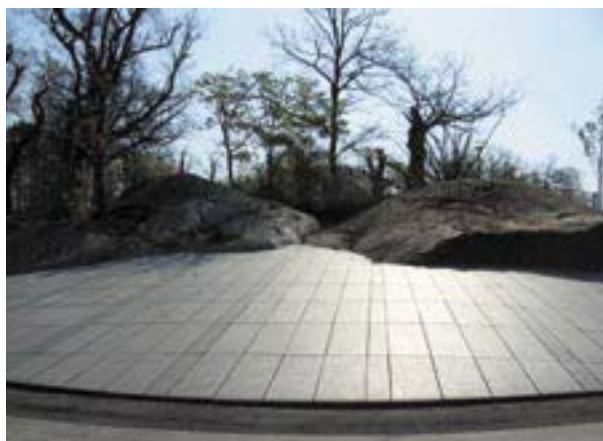
Fig 8.43 Släntbeklädning av granitplattor i parkmiljö.
