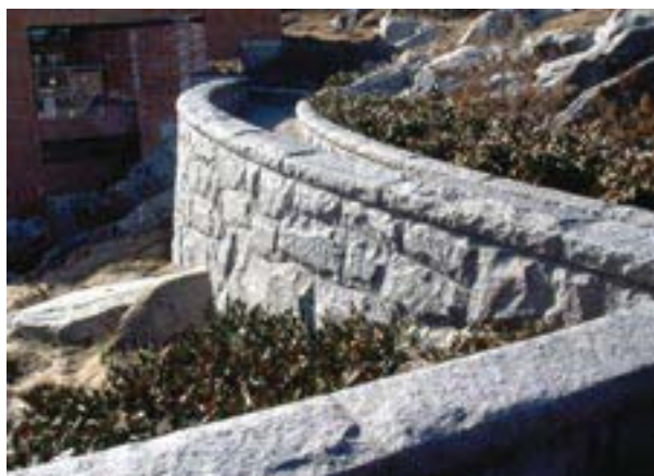
Fig 8.14 Mur av råkilad beklädnadsgranit, avtäckning av råkilad granit.
