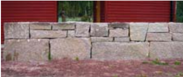
Fig 8.7 Kallmur av granitblock i rubbelförband
