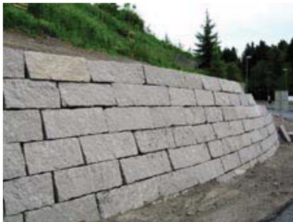
Fig 8.29 Kallmur av granitblock i vägsränning.
