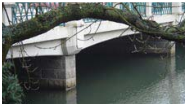
Fig 8.47 Brofundament klätt med beklädnadsgranit med bakstöd av betong.
