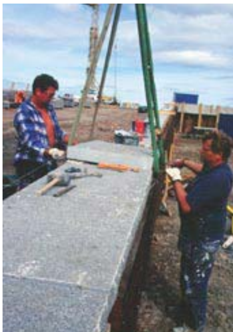
Fig 8.46 Granitavtäckning monteras
