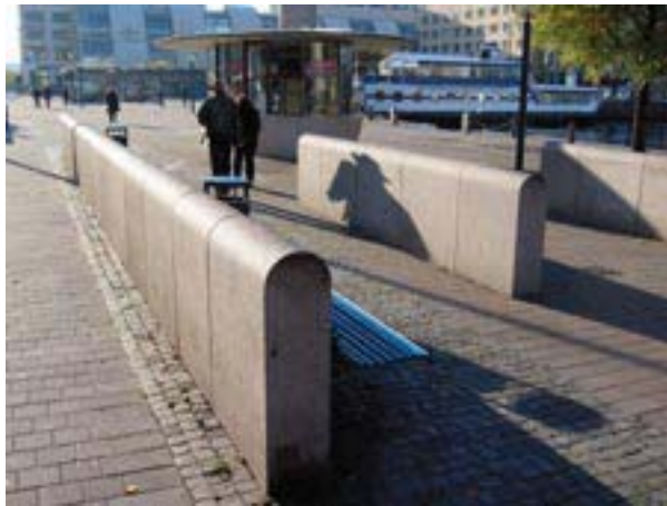
Fig 8.26 Blockstensmurar av flammad granit.
