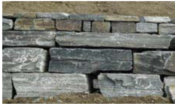
Fig 8.18 Kallmur av staplade skifferblock i kvaderförband.
