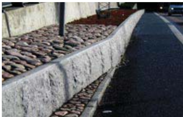
Fig 8.48 Blockstensmur av granit som stödmur och trafikbarriär
