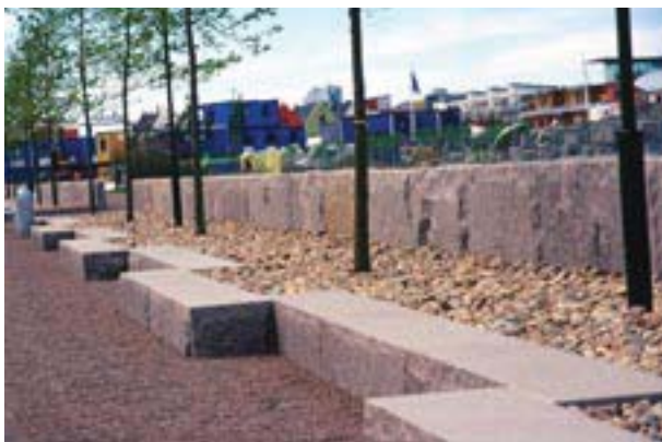
Fig 8.35 Två varianter av blockstensmur.
