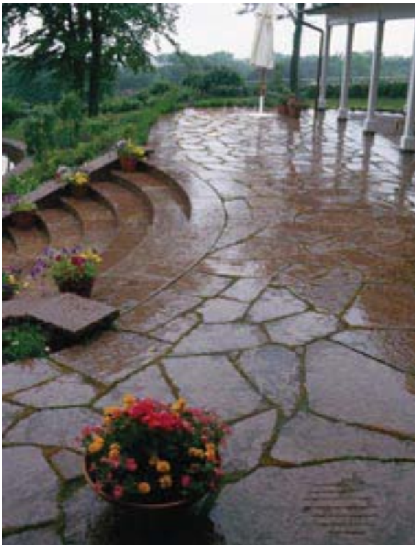
Fig 4.14 Altan med topphyvlad kalksten i oregelbundet mönster.
