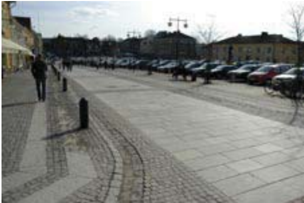
Fig 4.24 Gårdsgata med beläggning av granithällar och smågatsten
