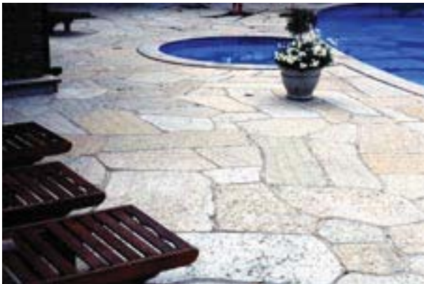
Fig 4.22 Topphyvld kalksten i oregelbundet mönster runt pool.
