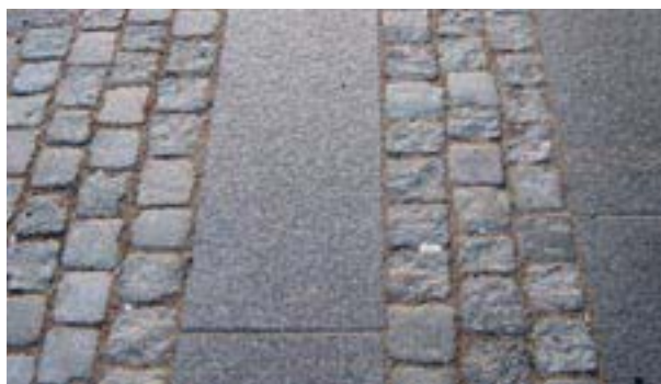
Fig 4.4 Granithäll med klippt kant mot gatstensbeläggning
