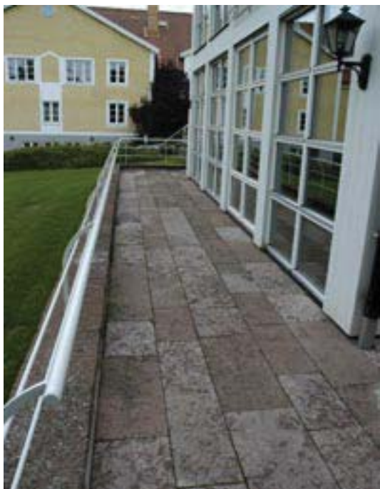
Fig 4.3 Toppiphyvlade kalkstenshällar i fallande längder
